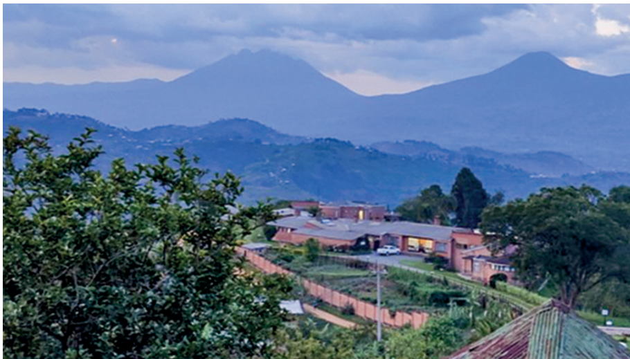
Overzicht retraitecentrum Remera - Ruhondo
