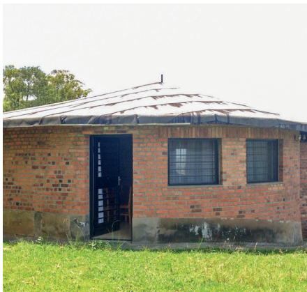
De nieuwe dakbedekking
