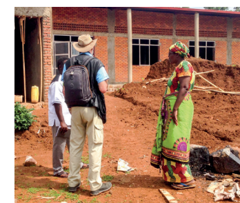
Bezoek school in aanbouw februari 2020
